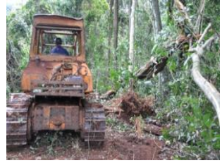
Đào rễ cây bằng máy ủi
